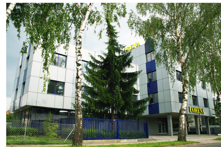
Lorena Produktionsgebäude Haid bei Ansfelden / Österreich
